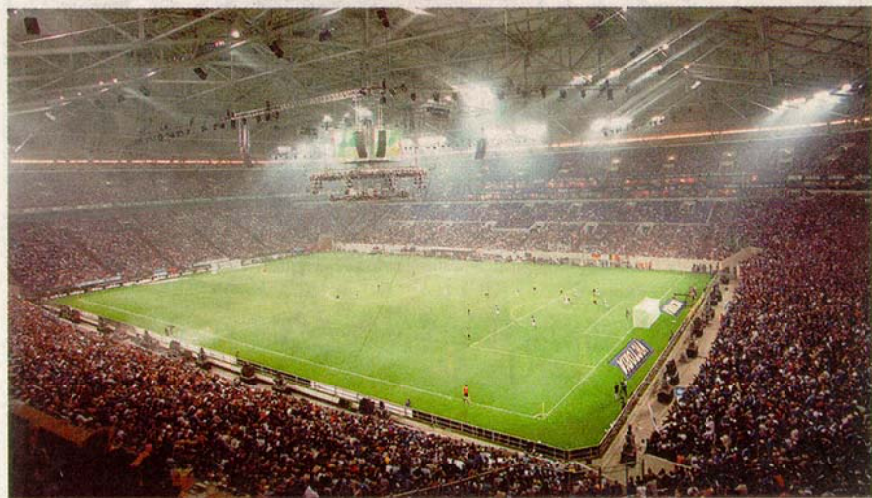
Die Arena „AufSchalke“ in Gelsenkirchen – hier wird die moderne Technik erprobt
