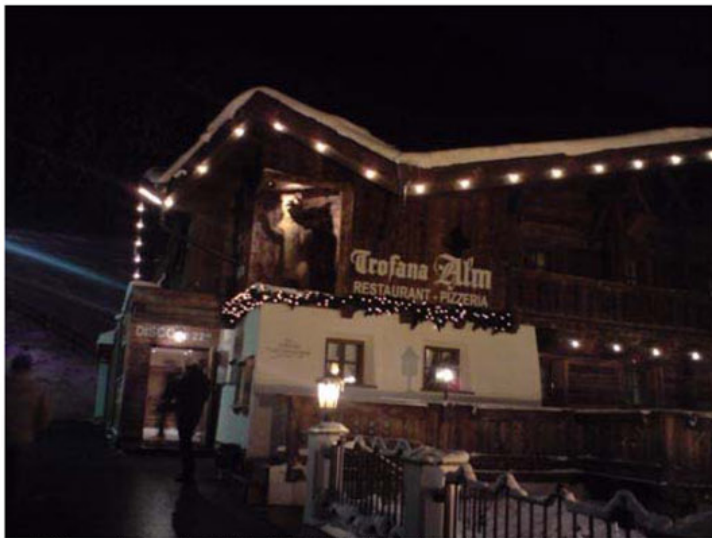
Zur Wintersportsaison in Ischgl hat die MIB GmbH die Ausschank-Kontrolle der Fass-Biergetränke in der Trofana Alm auf den neusten Stand gebracht.
