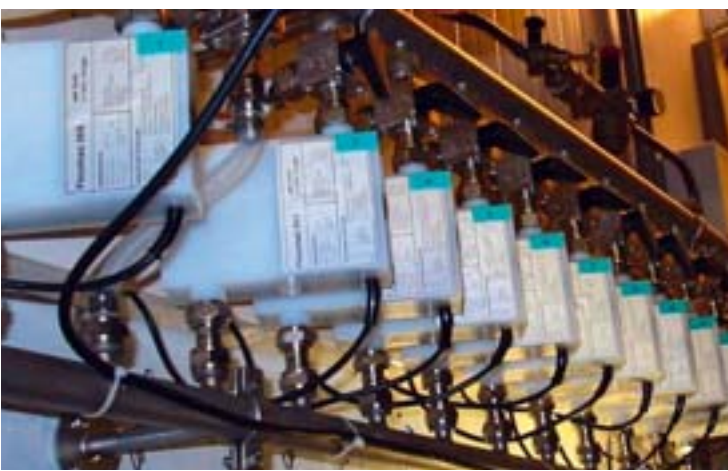
Typisches Beispiel aus der Getränkeindustrie: Mit einer Abweichung von \pm 1\% vom Messwert ist der Flowmax 40i ein Messgerät, das sich für die abrechnungsgenaue Messung von Volumenströmen anbietet. Alle mediumsberührten Teile bestehen aus PE-HD (Polyethylen High Density).
